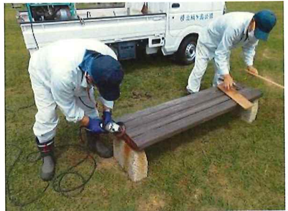
うみのね広場テーブルベンチ腐食部応急修繕
