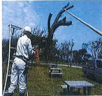
落下恐れ枝下ろし後
